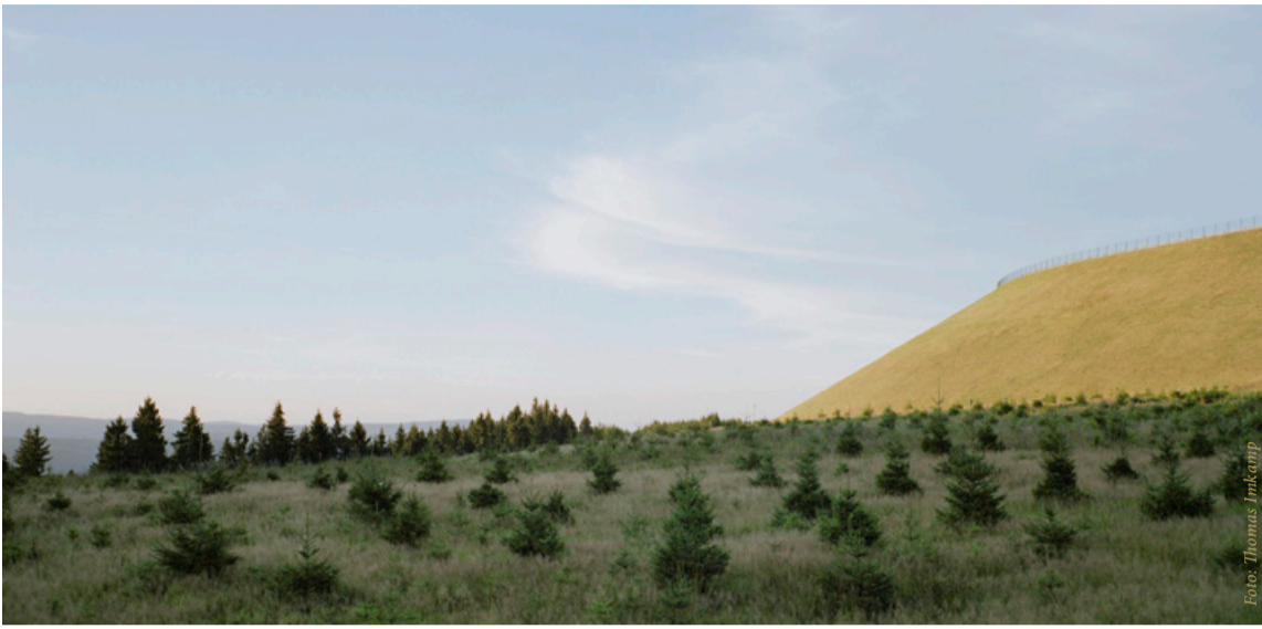
Trägt auch zur Energiewende bei: das Pumpspeicherkraftwerk Goldisthal wie es Thomas Imkamp in seiner Arbeit zeigt.
