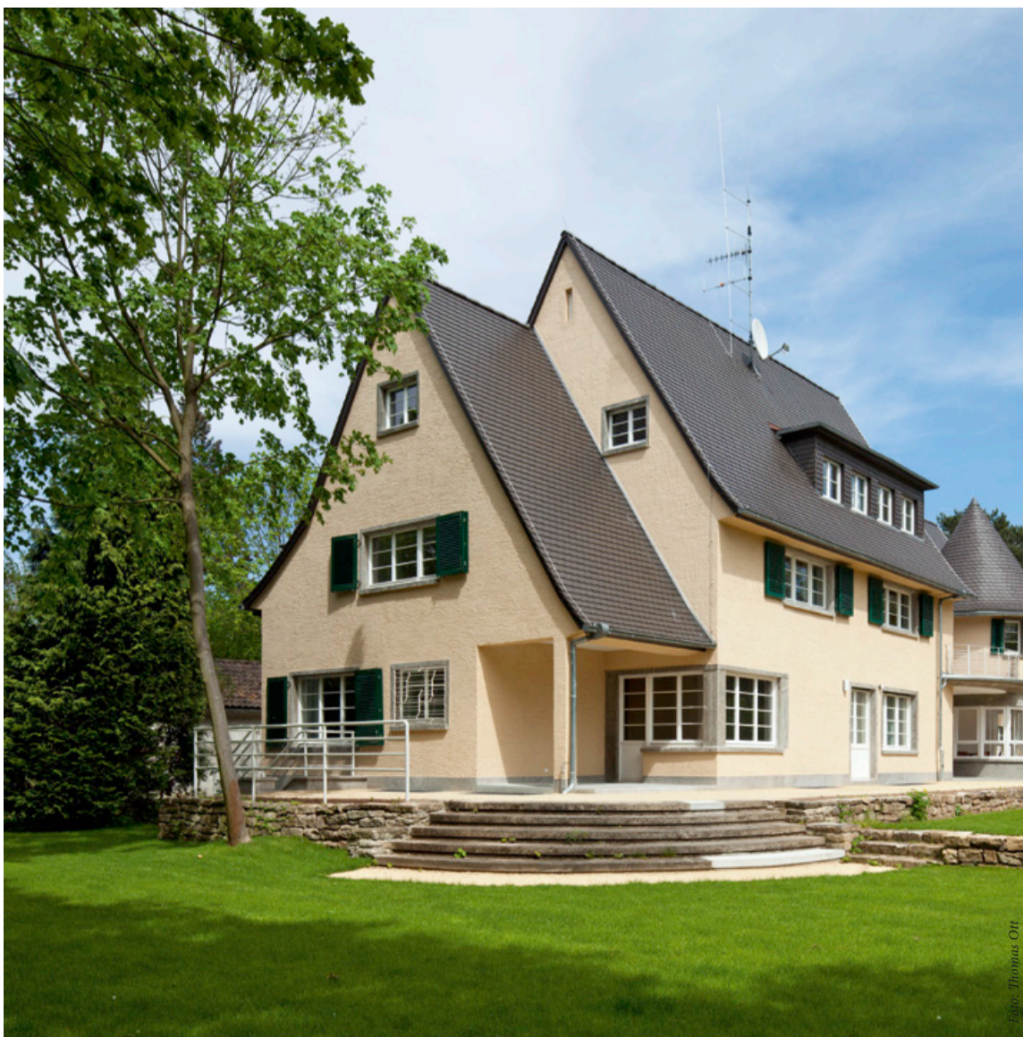
Komplett rekonstruiert wurde die großflächige Außenanlage, die wie das Internationale Gästehaus nun in neuer Schönheit erstrahlt.
