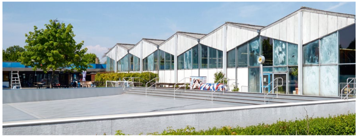
Trübe Aussicht durch so manche Nordbad-Scheibe. 2015 soll das marode Gebäude einem Neubau weichen.
